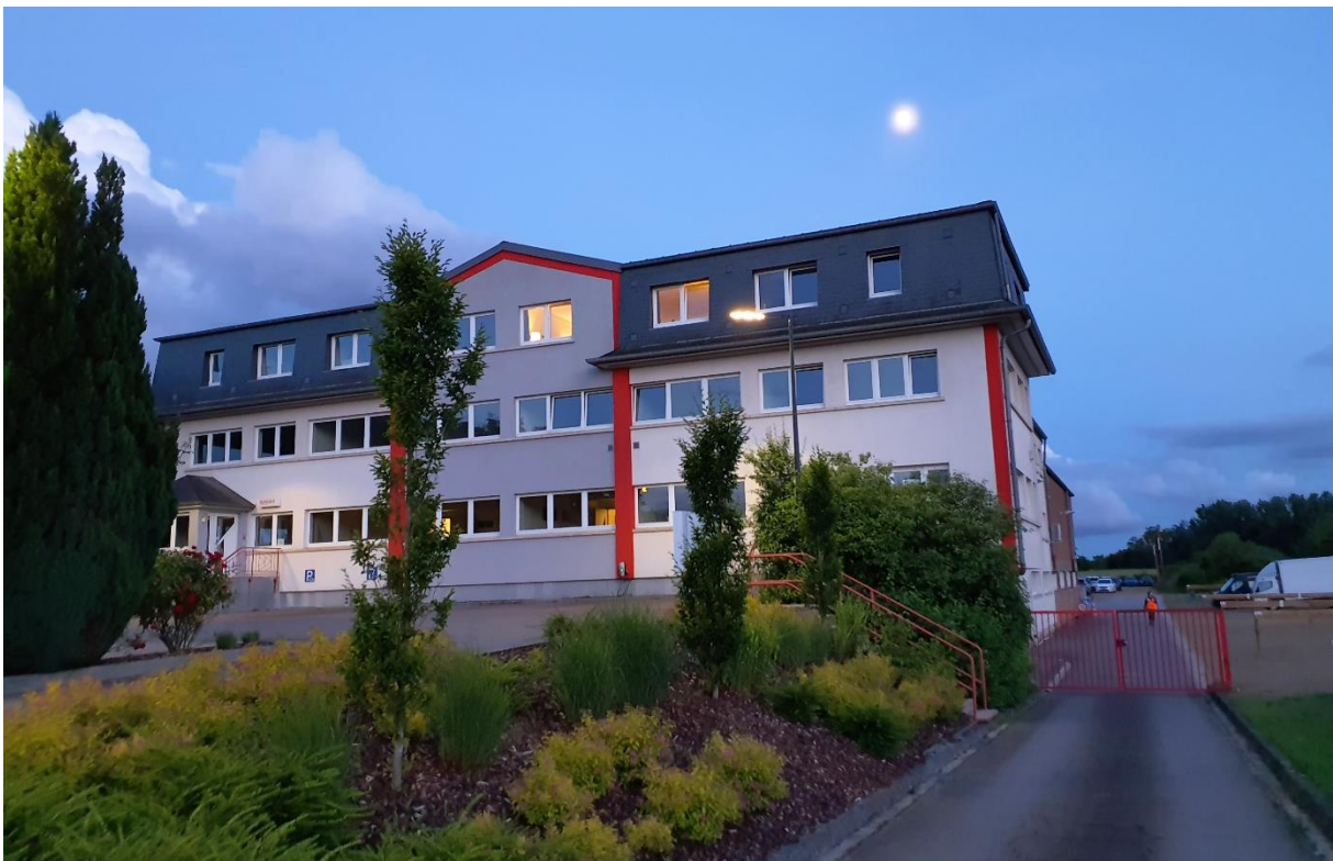
Abbildung 3: Gebäudekomplex im nördlichen VB (Blickrichtung Süden)
