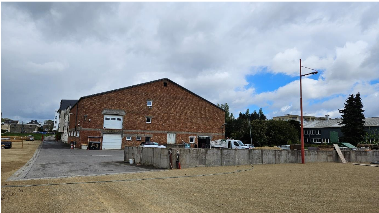
Abbildung 11: Gebäudekomplex mit Lagerfläche im nördlichen VB (Blickrichtung Norden)
