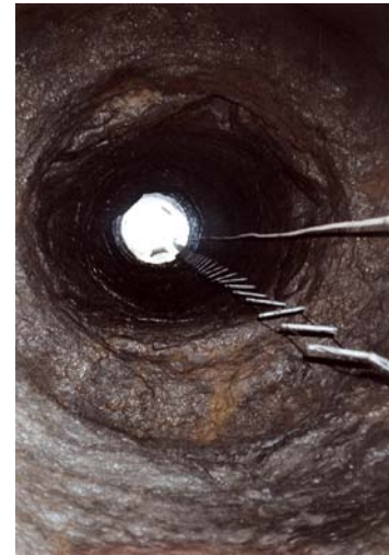
Fig. 14: Puits 7 vu d'en bas (profondeur: 20 m)
