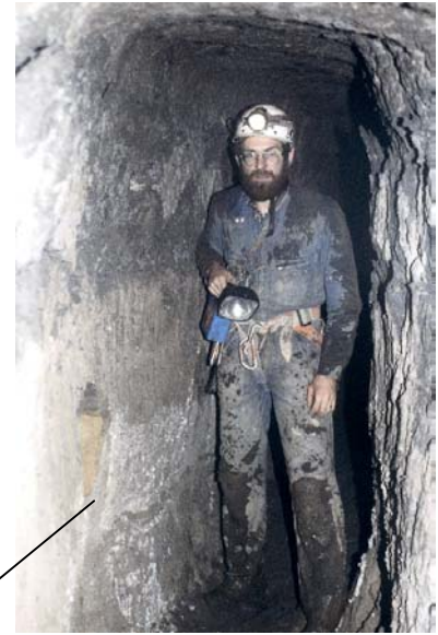
Fig.11 : Tunnel près du puits 7. Voûte horizontale et fond en biais adapté après la jonction de deux lots de construction
