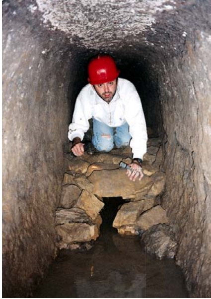
Fig. 18. Début de la conduite d'eau construite entre les puits 8 et 9
