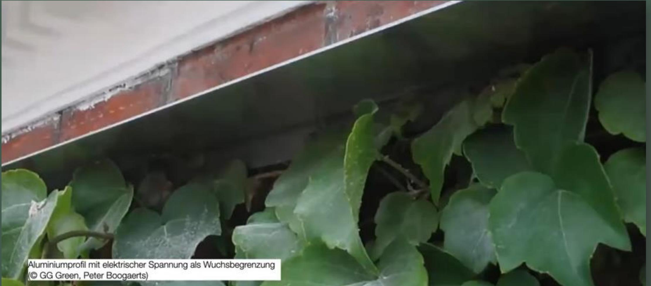
Aluminiumprofil mit elektrischer Spannung als Wuchsbegrenzung
